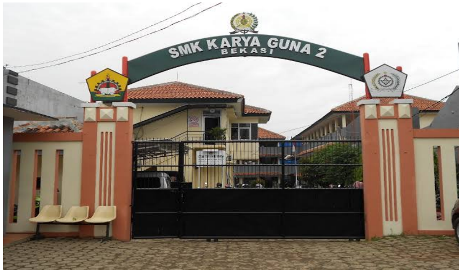
Gambar 1. 2. Gedung SMK Karya Guna 2 Bekasi
